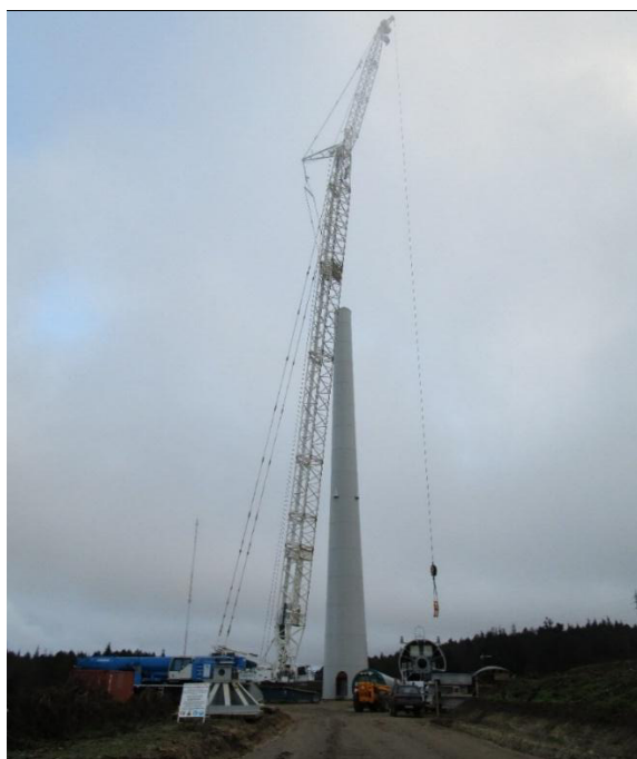
Fotografia 2.14 – Aspeto da plataforma de trabalho durante a montagem de um aerogerador
