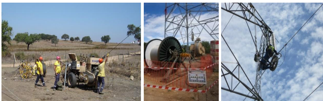
Fotografia 2.24 - Colocação dos cabos
