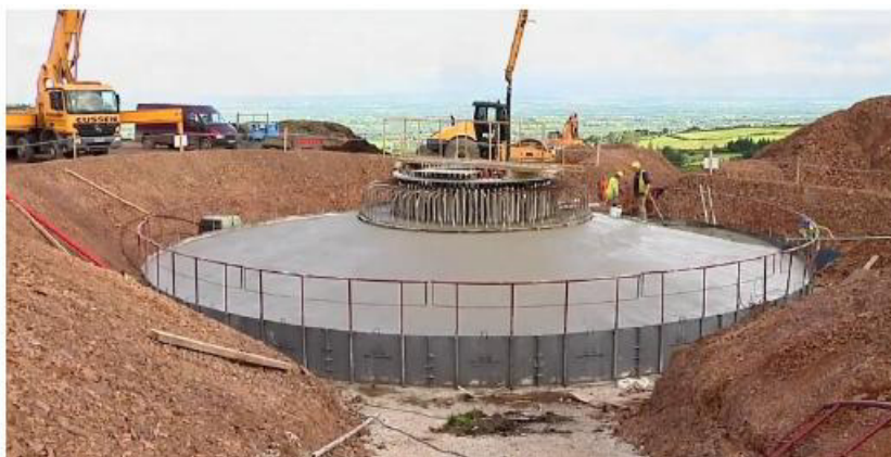
Fotografia 2.7 – Exemplo de uma fundação do aerogerador
