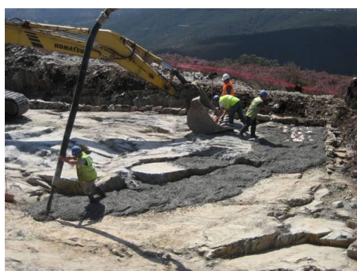
Fotografia 2.10 – Betonagem do betão de limpeza da fundação
