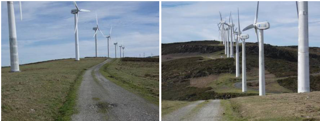
Fotografia 2.2 - Exemplo da plataforma de um aerogerador após recuperação
