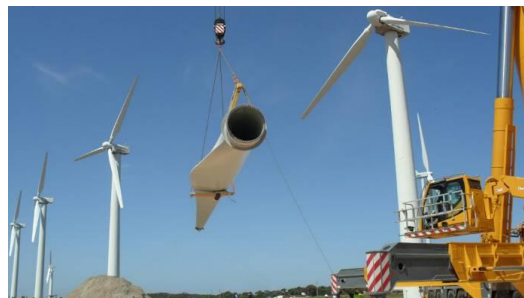
Fotografia 2.20 – Montagem de pás
