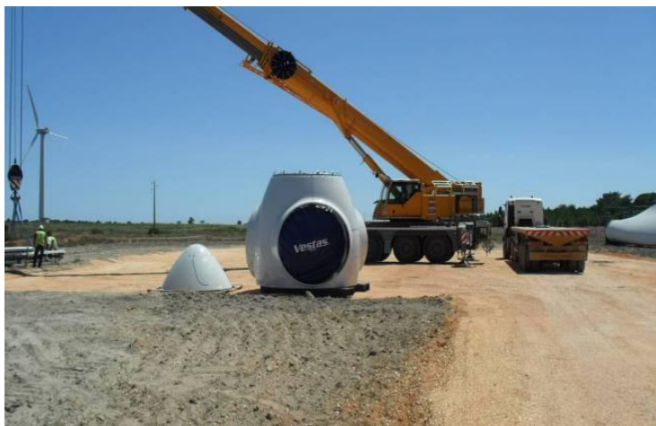
Fotografia 2.1 - Exemplo da plataforma de um aerogerador no decorrer das montagens
