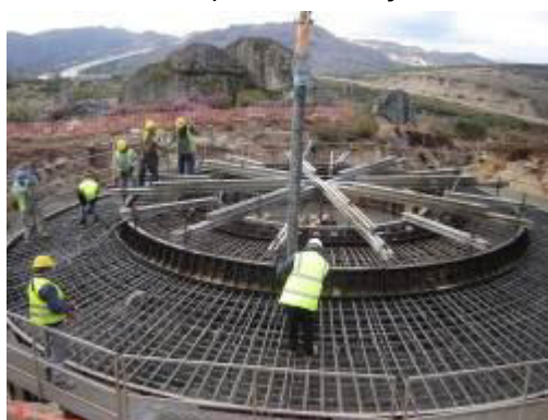
Fotografia 2.12 – Armação do aço
