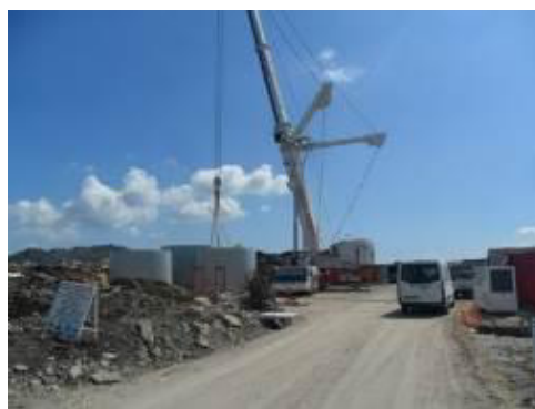
Fotografia 2.18 – Montagem da torre
