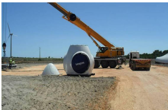
Fotografia 2.17 – Plataforma de montagem
