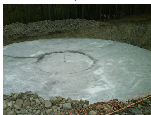
Fotografia 2.11 – Betão de limpeza
