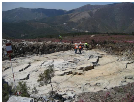
Fotografia 2.9 – Cabouco após escavação e limpeza
