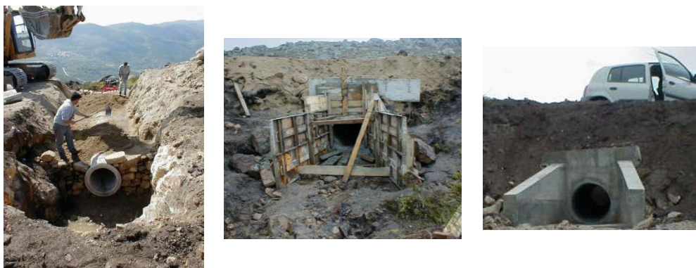
Fotografias 2.4, 2.5 e 2.6 – Construção de uma passagem hidráulica
