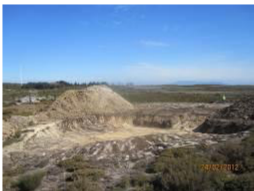
Fotografia 2.8 – Escavação do cabouco
