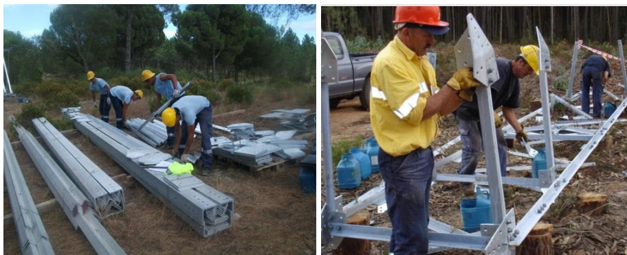
Fotografia 2.22 – Preparação da montagem da estrutura dos apoios
