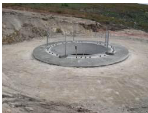
Fotografia 2.13 – Fundação aterrada
