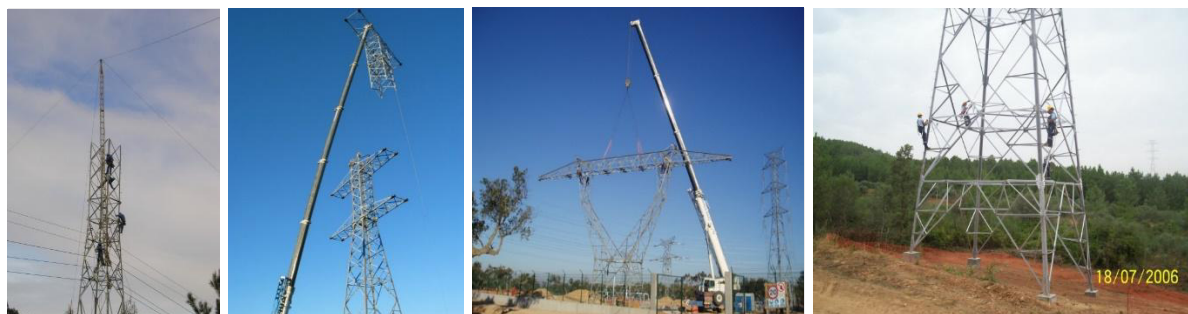
Fotografia 2.23 - Montagem da estrutura dos apoios
